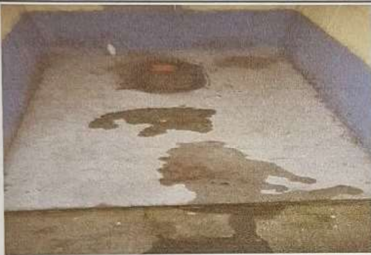
Foto 3: Desinstalación de 3 Tazas
