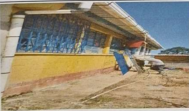
Foto 5: Recibimiento de balcones de hierro en ventanas en la escuela
