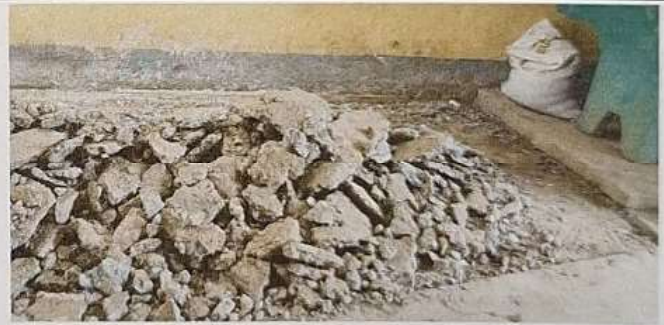
Foto 6: Desinstalación de piso torta del corredor de aulas Módulo 2
