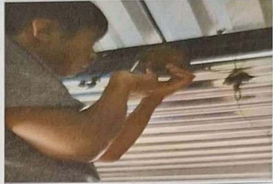
Foto 2: Instalación de cableado de Energía Eléctrica de 5 aulas y corredor
