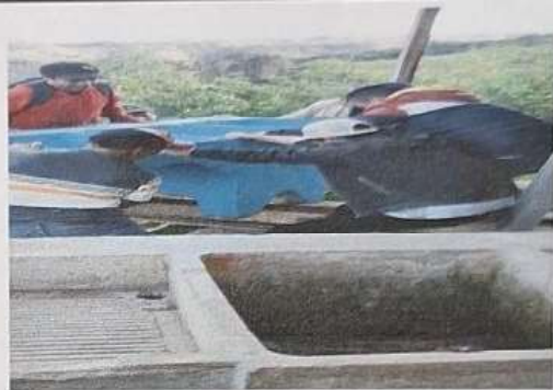
Foto 4: Desinstalación de Pileta en mal estado
