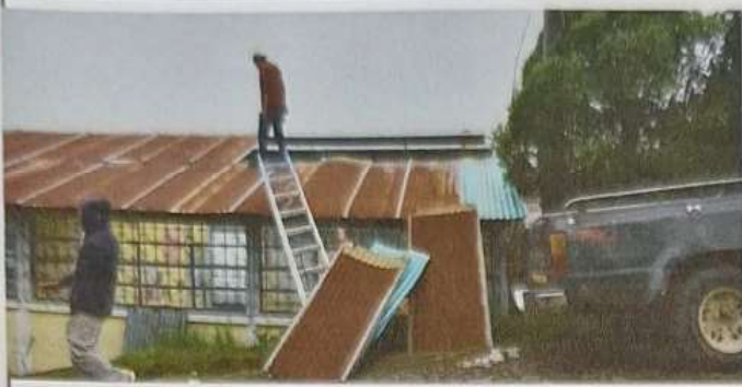
Foto 1: Desinstalación de lámina Aulas Módulo 1, 3 Aulas
